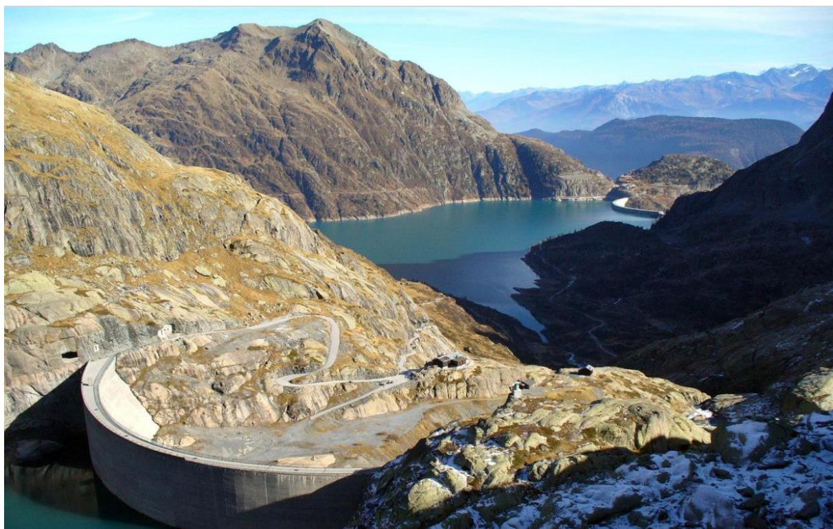
Le jour de la rentrée, la classe de TF accompagnée de Mme RAMBAUD et Mme THIERY est allée visiter la STEP du Nant de Dranse. Nouvellement construit (entré en fonctionnement en juillet 2022), ce gigantesque ouvrage permet de stocker de l'énergie électrique en remontant une partie de l'eau du barrage pour stocker de l'électricité quand elle est produite en trop grande quantité.
